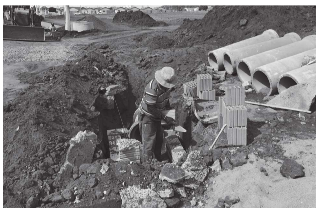
Funcionário do Departamento de Obras trabalha na interligação do sistema de drenagem urbana.
