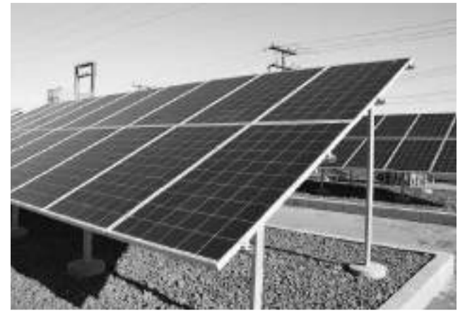
A instalação de placas solares nos prédios públicos permitirá a economia com gastos de energia, que é de R$ 350 mil/ano.
