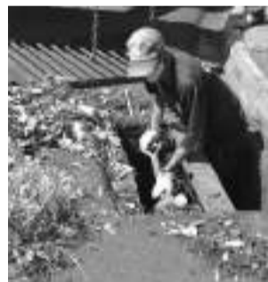
Servidor executa limpeza em bueiro.
