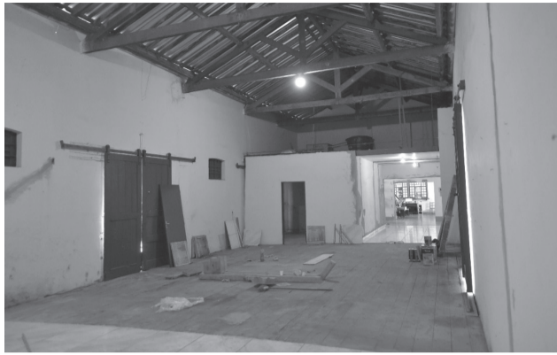
Mesmo com as obras de reforma o Museu permanece aberto à visitação.
