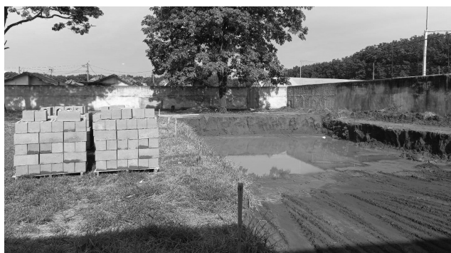
A construção da piscina está na fase inicial e a previsão é que obra esteja concluída dentro de 30 dias.
