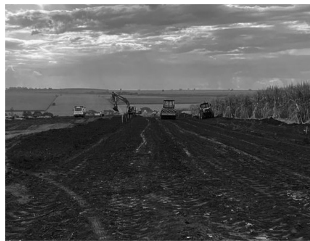
O alargamento e compactação do leito carroçável é uma das melhorias executadas na vicinal, que liga o município a Terra Roxa.
