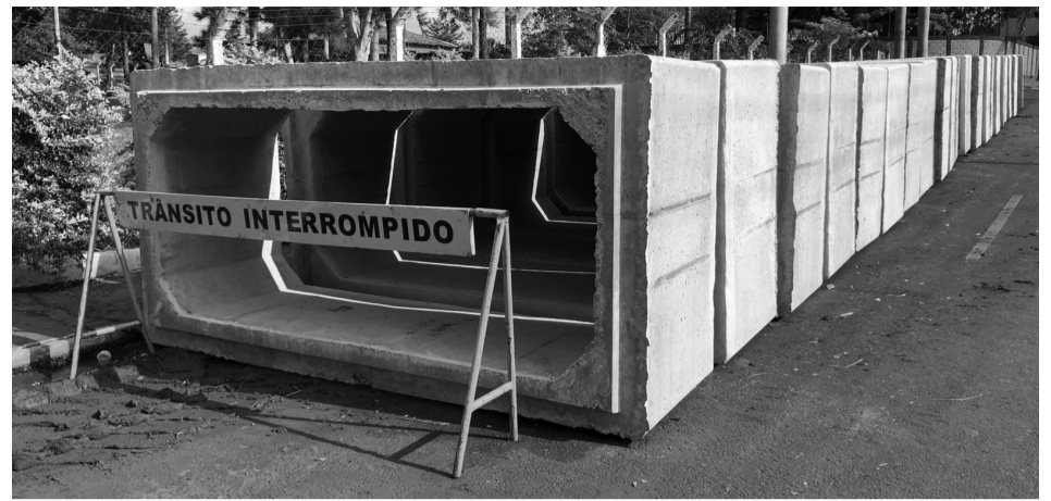
Tubos de concreto usados na construção do novo ramal de galerias pluviais.
