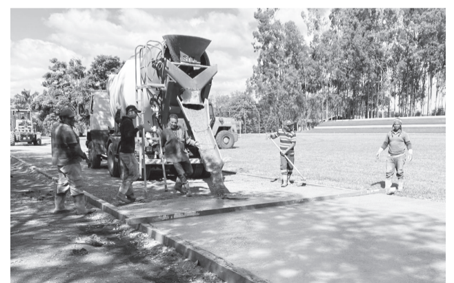
Servidores trabalham na concretagem da pista de atletismo.
