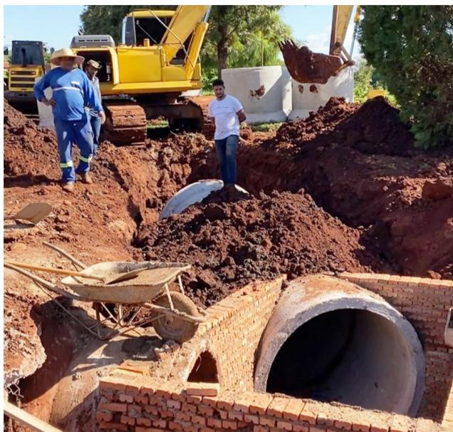
Funcionários e máquinas trabalham na construção das novas galerias pluviais que vão impedir o assoreamento do lago.
