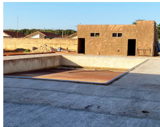
A piscina semiolímpica recebeu revestimento de pedra ao seu redor.
