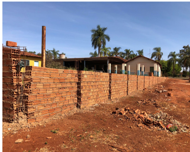
A Casa do Pajé está sendo construída no terreno onde funcionou a antiga Creche Curumim.
