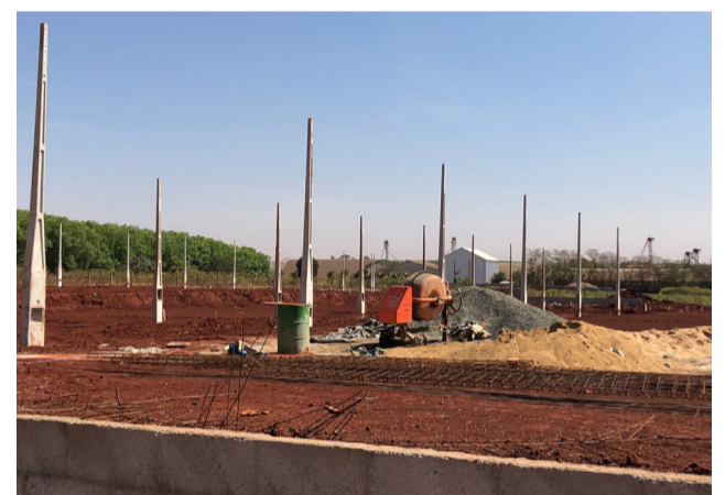
Obras na área que abrigará o novo conjunto habitacional da cidade.
