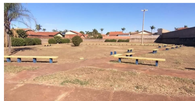
Construção da nova pista de skate na praça “Osvaldo Frangiosi”.
