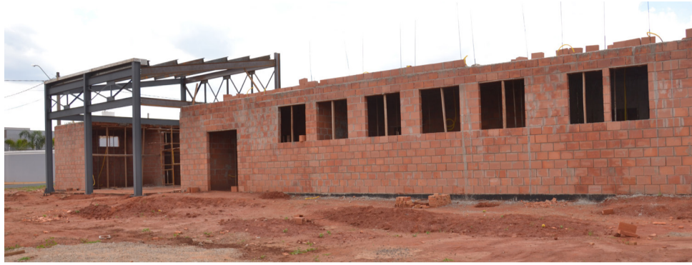
Construção no Jardim Rama que abrigará unidade de saúde para atendimento dos moradores daquela região.
