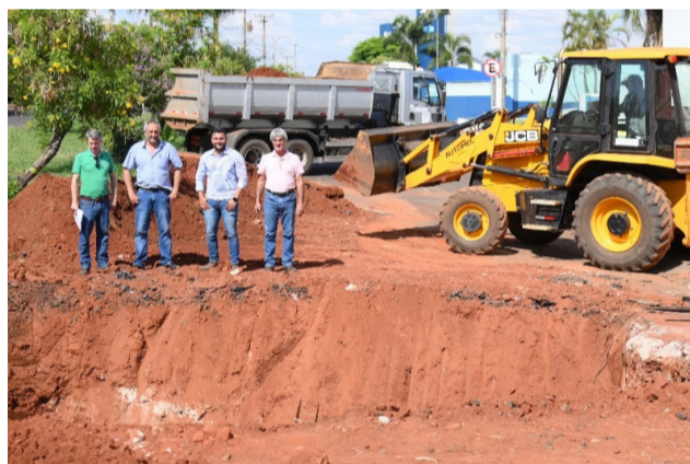
Dieb, secretários Luciano (Obras) e Jaci (Planejamento/Meio Ambiente) com o representante da empresa que executa os serviços.
