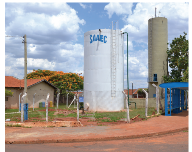
Um dos poços está sendo perfurado ao lado da creche da Cohab 3.
