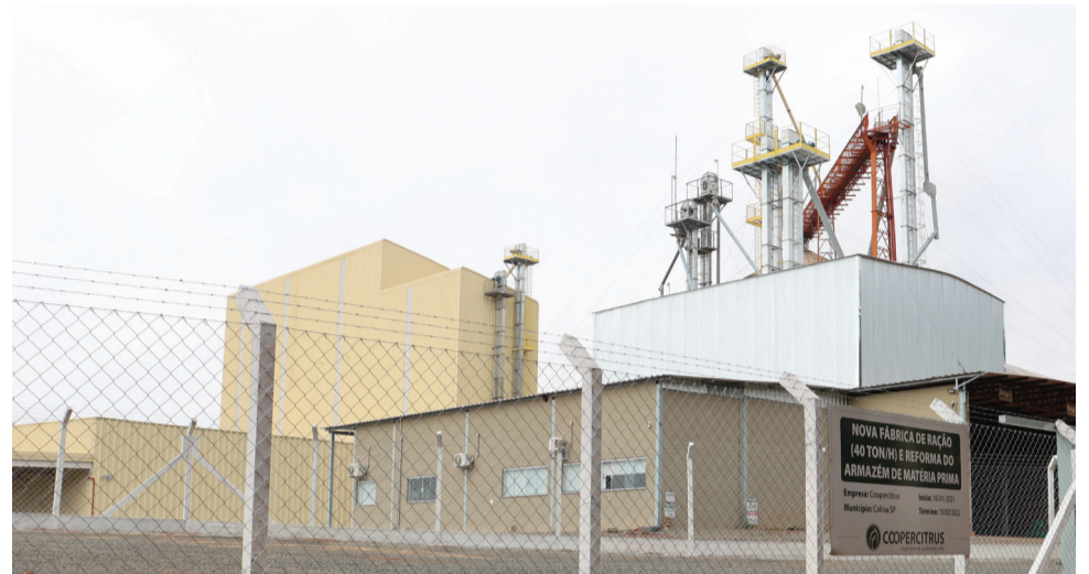
A cooperativa investiu R$ 15 milhões na construção da fábrica de rações, que está absorvendo mão de obra local.
