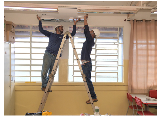
Funcionários trabalham na adequação da parte elétrica nas escolas municipais.
