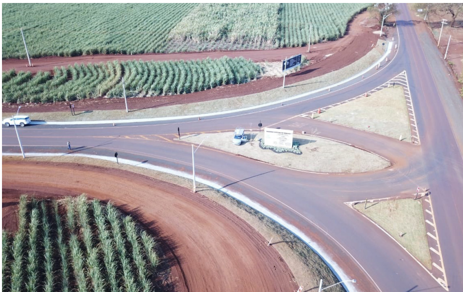
Vista aérea do trevo de acesso à Vicinal “Tute Vaz de Almeida”, inaugurada no dia 25.
