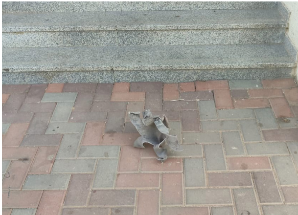
Parte de míssil que caiu na entrada do prédio onde a colinense reside com a família.
