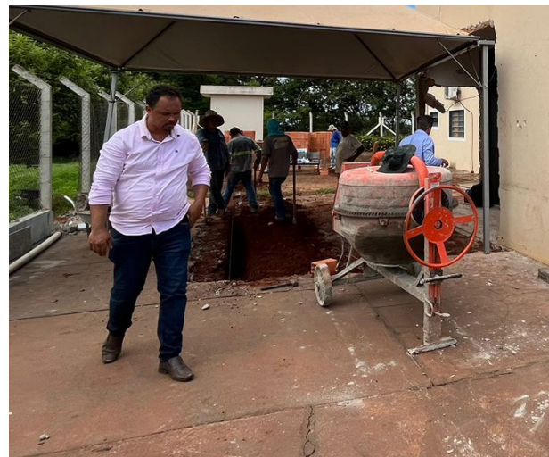
Funcionários trabalham nas obras de reforma e ampliação da unidade de saúde.
