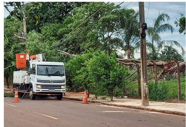
Funcionários da CPFL trabalham na manhã de segunda-feira para restabelecer energia no Jardim Hípico após queda de árvore na rede elétrica.
