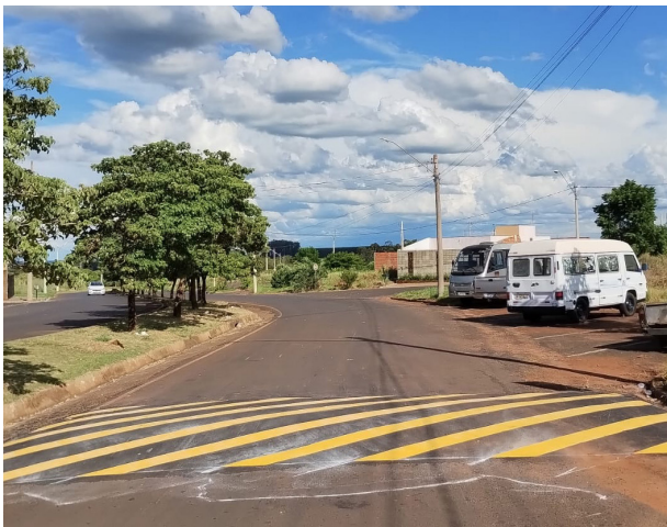
Lombada executada na Avenida das Cohabs, importante via da cidade. Pág. 3
