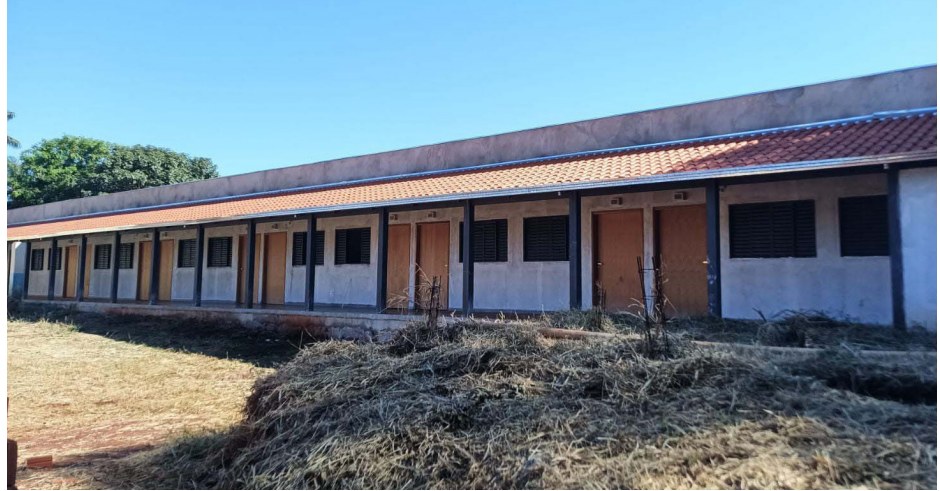
Etapa concluída da obra que compreende a construção de 14 apartamentos.
