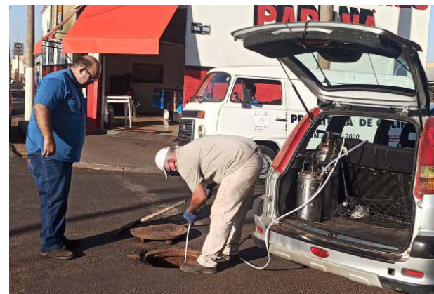
Servidor acompanha aplicação de inseticida em poço de visita.
