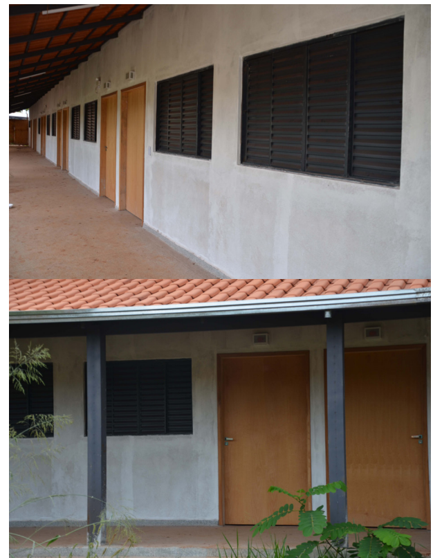
A assistência à terceira idade em Jaborandi se tornará referência na região quando a obra estiver concluída e atendimento começar.
