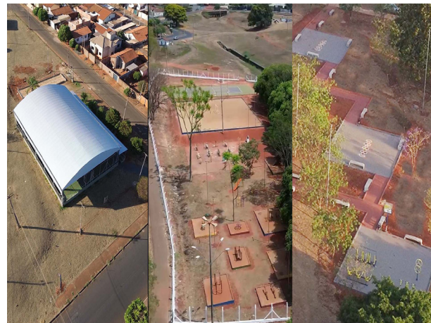
Vista aérea das três obras inauguradas na noite do último dia 26, que beneficiam moradores de vários bairros.
