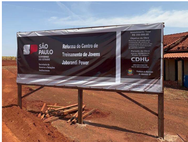
Placa da obra instalada nas futuras instalações da primeira empresa pública de energia solar da cidade.
