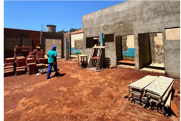
Obras estão a todo vapor para iniciar o atendimento dos idosos.
