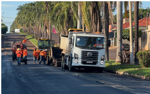
Trabalhadores aplicam nova camada de pavimento em uma das ruas recapeadas da cidade.
