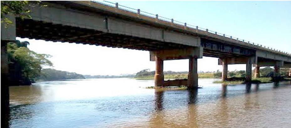
Ponte sobre o Rio Pardo onde os ranchos estão instalados.
