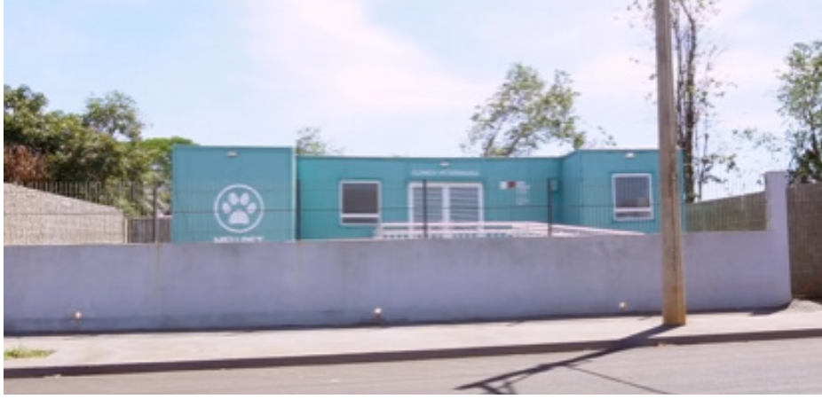
Estrutura que após a reforma abrigará o Pet Contêiner e o SUS Cão.
