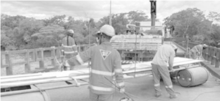
Funcionários trabalham no tabuleiro da ponte, divisa de MG e SP.
