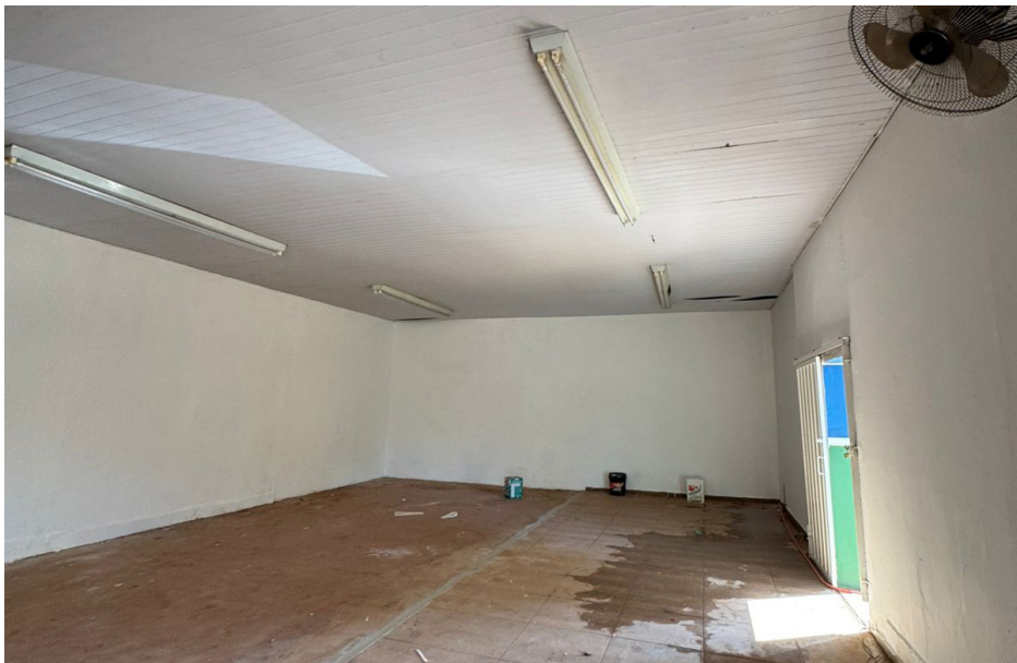
Parte interna do prédio que está sendo reformado e reestruturado.
