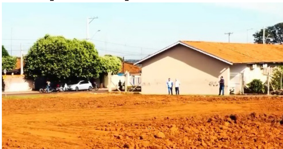
A área que abrigará a nova UBS foi alinhada com a terraplanagem.
