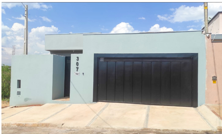
Fachada de uma das residências construídas pela empresa.
