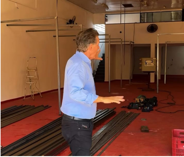
Silvinho tem acompanhado de perto a reforma do prédio e a instalação dos boxes.
