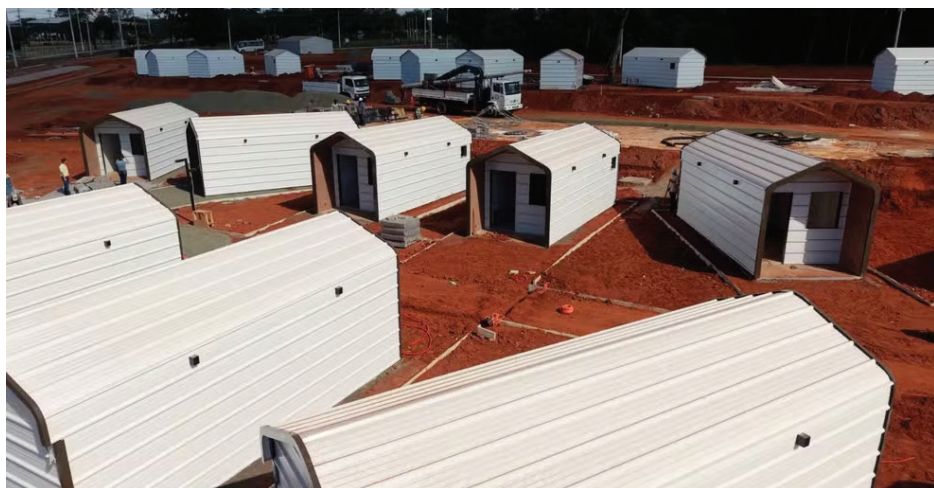
Cabanas instaladas na área de camping do Parque do Peão.
