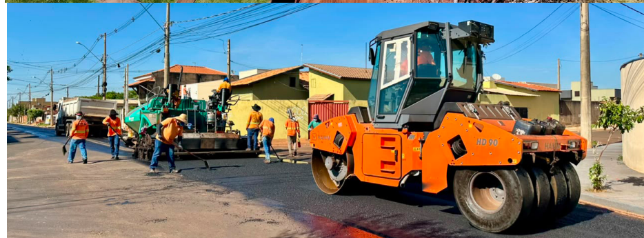
Obras em execução com recursos destinados pelo parlamentar.
