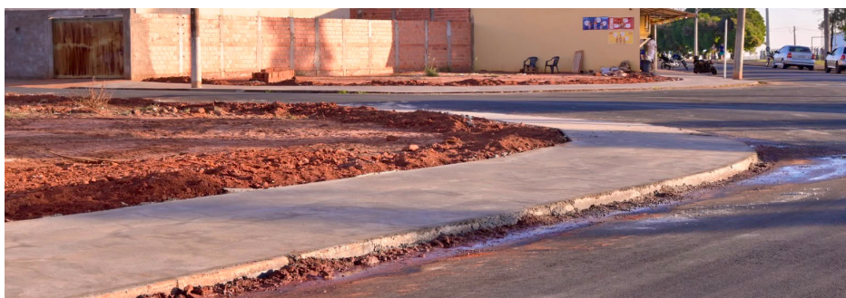
Calçamento construído na Vila Hípica com os recursos destinados pelo parlamentar.
