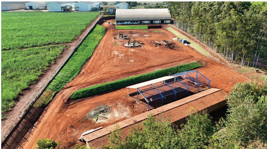
Obras do complexo que abrigará o Parque Botânico que está em construção.
