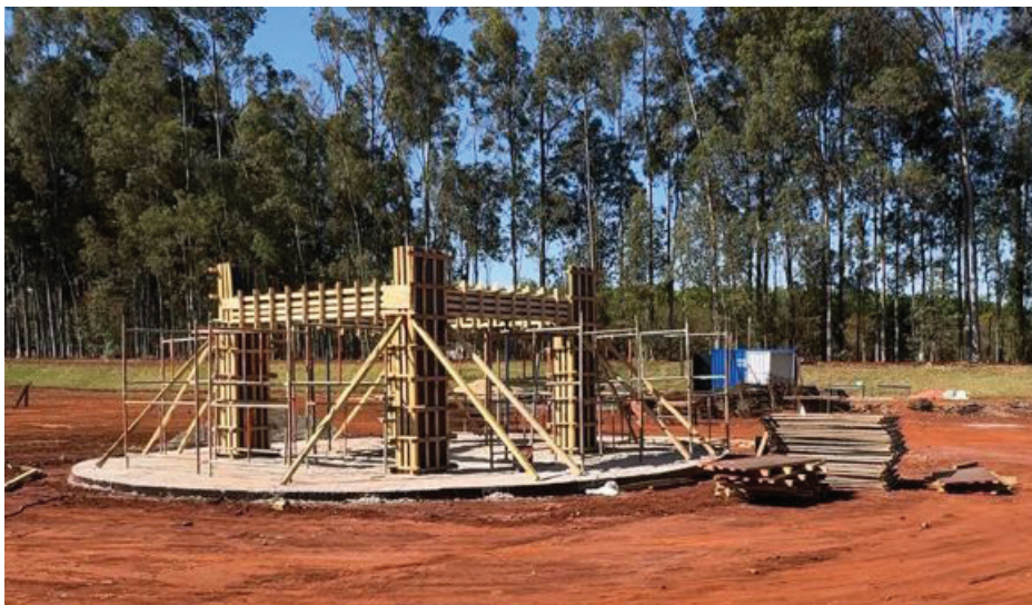
Base das escadas do maior vaso do mundo, que terá altura de 9,30 metros.
