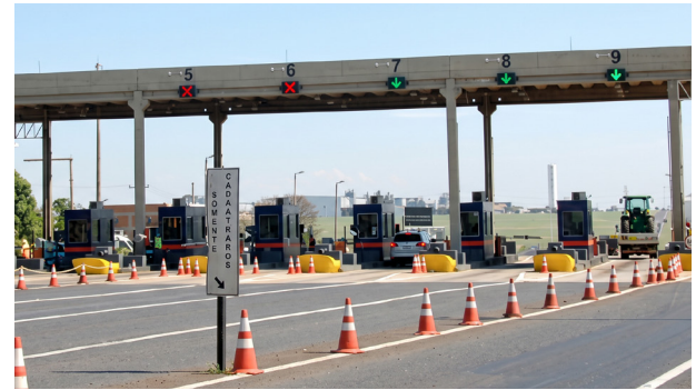
Praça de pedágio em Colina que, em dezembro, será substituída por portal eletrônico.
