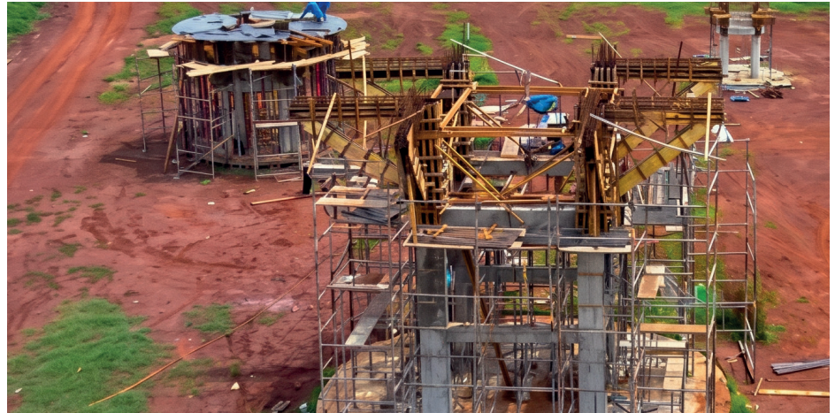
A construção do maior vaso do mundo começa a ganhar forma.
